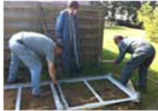
Positionner les bases sur un sol nivelé
