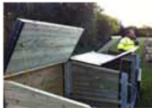
Poser la plateforme et les couvercles
